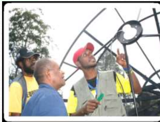
アンテナ設置
